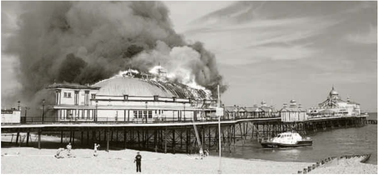
Löscheinsatz am Eastbourne Pier: von der Haupthalle ist nur noch das Metallgerippe erhalten
