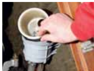
Der Grund wird stark aufgewirbelt - überprüfen Sie den Kühlwasserfilter.
