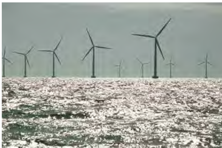
Offshore-Windpark bei Nysted.
