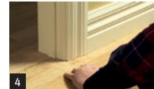
1. Verwenden Sie die Rückseite des neuen Fußbodenbelags als Richtschnur und machen Sie einen Schnitt in der entsprechenden Länge.
