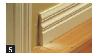
Verwenden Sie eine Hälfte der Klingenkante, um mit dem Schnitt zu starten; beginnen Sie dabei von der Oberseite der Sockelleiste. Versuchen Sie, nicht die ganze Klingenkante in das Holz zu versenken; wenn Sie die andere Hälfte der Klingenkante außerhalb der Oberfläche lassen, bewahren Sie die Kontrolle. (1-3) Entfernen Sie den Verschnitt. (4-5)
